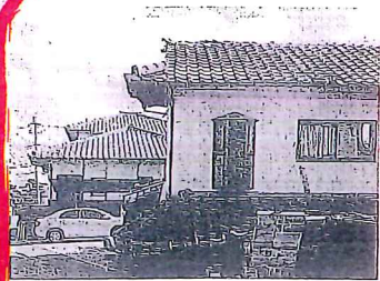
益城町。1階が崩れた住宅の隣に、大棟から下層までしっかりした住宅＝森田氏提供
